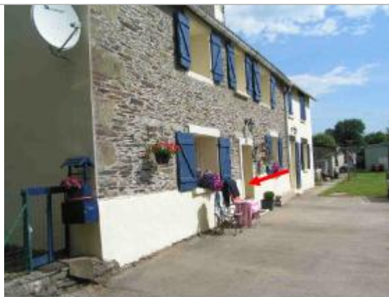
55 cm d'eau sur le plancher.
