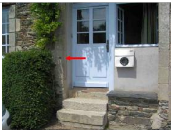
Repère de crue fixé sur le montant gauche de la porte d'entrée.
