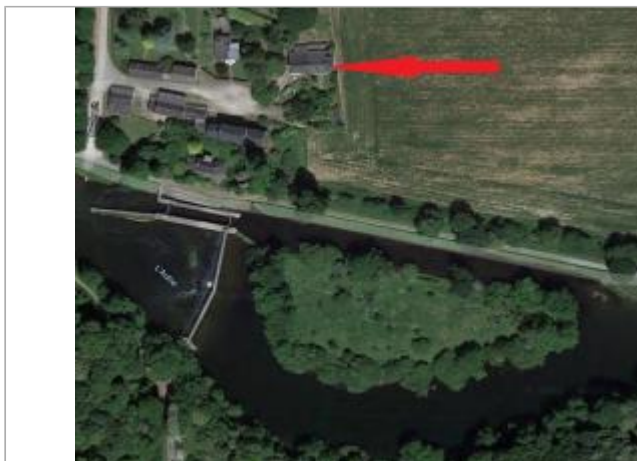
Photographie aérienne du bâtiment au lieu-dit Boudrac'h à Châteauneuf du Faou
