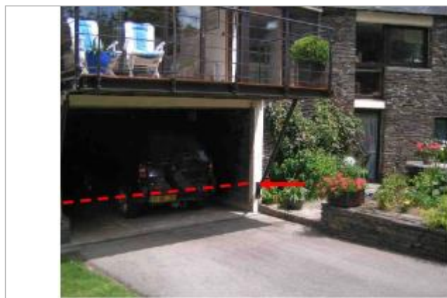
L'eau a atteint une hauteur de 62cm au dessus du carrelage du garage.
