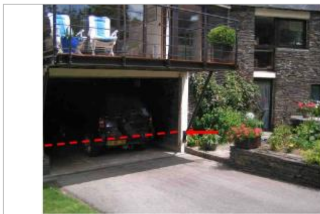
L'eau a atteint une hauteur de 62cm au dessus du carrelage du garage.
