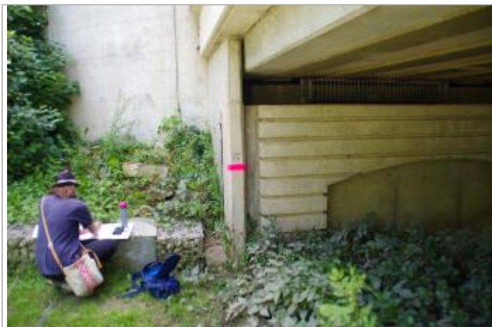
Pont sur l'avenue de la forêt
