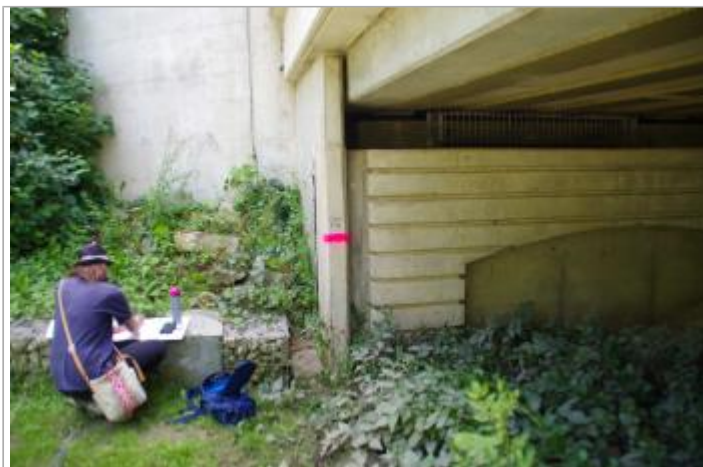
Pont sur l'avenue de la forêt
