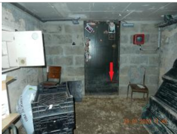
Laisse de crue à 73 cm au dessus du sol de la cave
