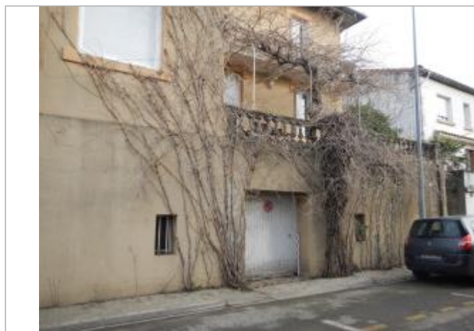
Laisse de crue au niveau de la moitié de la hauteur du gabion
