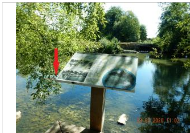
Laisse de crue sur la partie supérieur du pupitre
