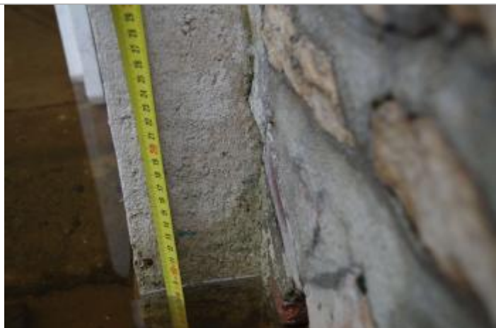
Laisse de crue sur mur d'encadrement du garage
