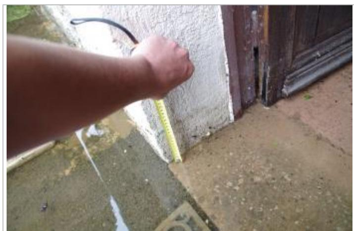
Laisse de crue sur mur d'encadrement de la porte d'entrée
