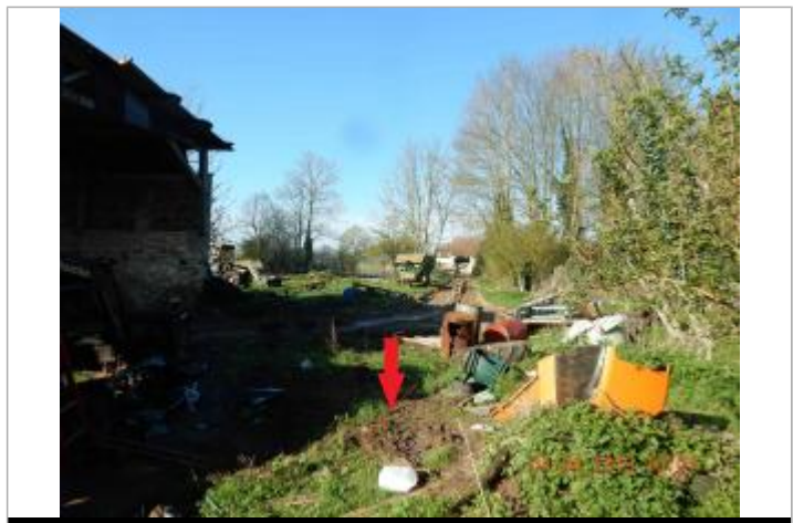
Laisse de crue sur le sol de la cours
