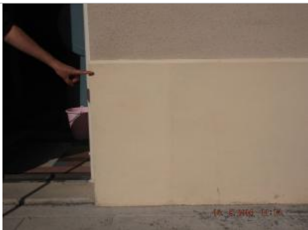
Laisse de crue sur mur façade Ouest
