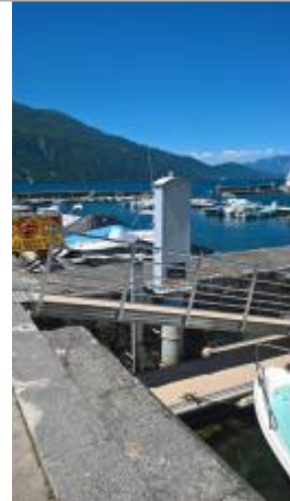
Repère de crue 1990 et 1944 au grand port
