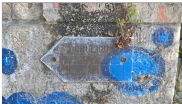
repère de crue 15 février 1990
