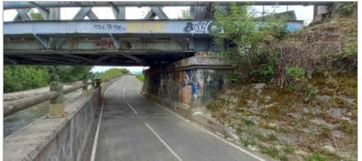
Pont sncf en bordure de piste cyclable, rive gauche de la Leysse
