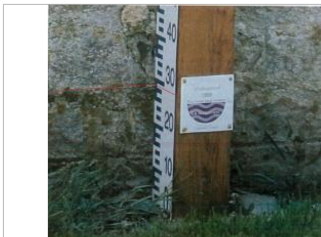
Trace d'humidité sur le mur
