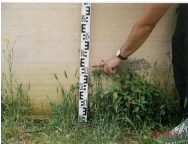
Laisse de crue sur le bas du mur d'une habitation
