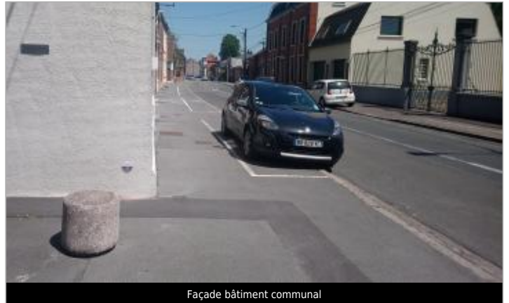
Façade bâtiment communal
