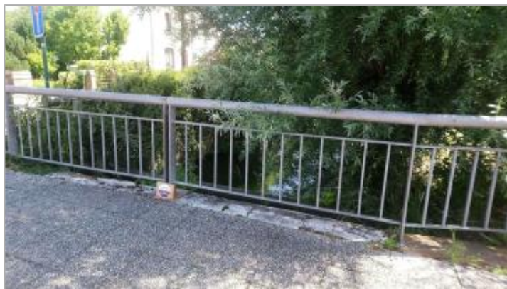
Repère de crue en rive gauche de la Blanche
