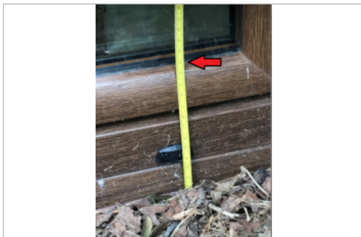
Laisse de crue 13 cm/sol au niveau de la fenêtre côté Seine
