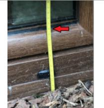
Laisse de crue 13 cm/sol au niveau de la fenêtre côté Seine
