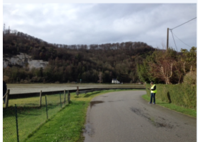
Muret en ciment, rue du Perrey dans le virage à gauche.
