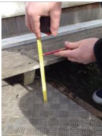
Laisse de crue 4 à 5 cm au dessus de la marche de la véranda
