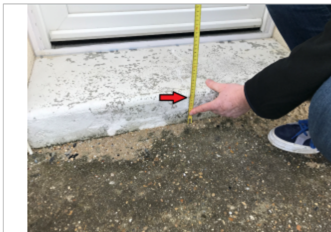
Laisse de crue au niveau de la marche de la porte d'entrée
