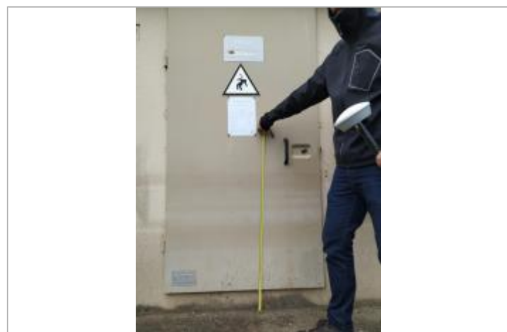
Vue de la laisse - Auteur : DDTM2A
