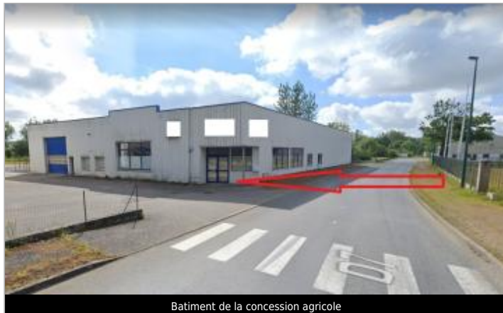
Batiment de la concession agricole
