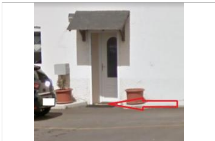
Seuil de la porte d'entrée de la maison
