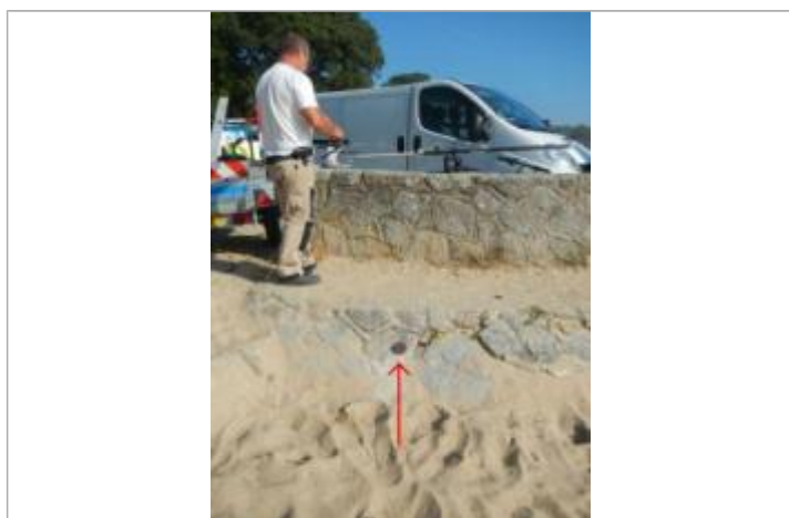
Sableaux Sud - Perré en pierre
