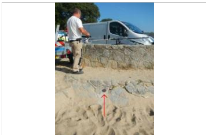
Sableaux Sud - Perré en pierre
