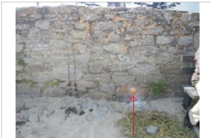
Petit Vieil - Muret en pierre
