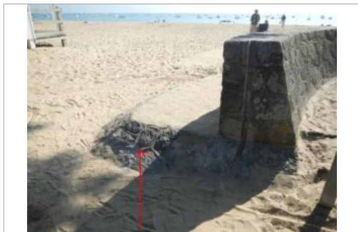
Sableaux Nord - Perré en pierre
