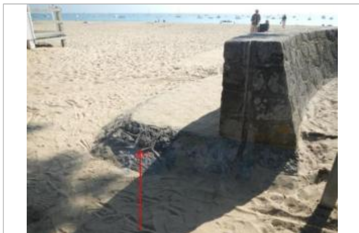
Sableaux Nord - Perré en pierre
