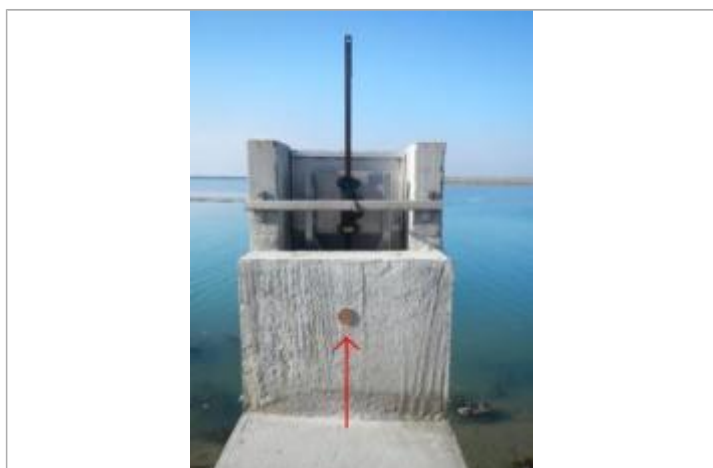
Jetée Jacobsen - Ouvrage hydraulique
