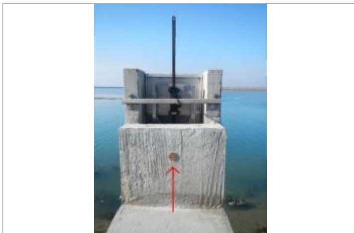
Jetée Jacobsen - Ouvrage hydraulique
