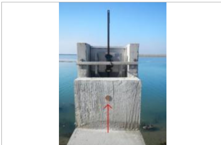
Jetée Jacobsen - Ouvrage hydraulique
