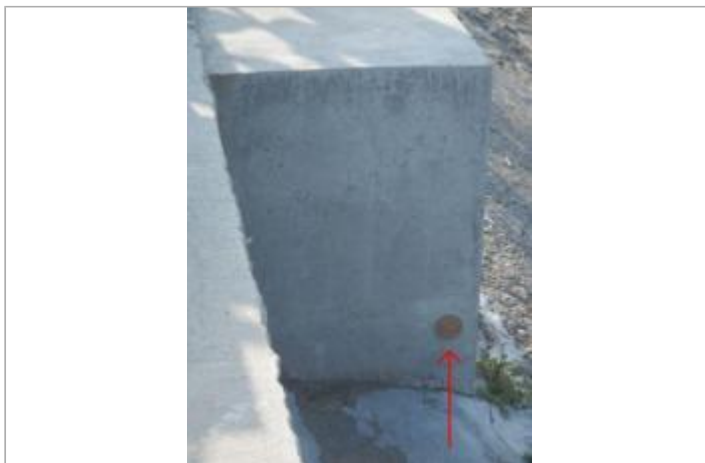
Jetée Jacobsen - Escalier
