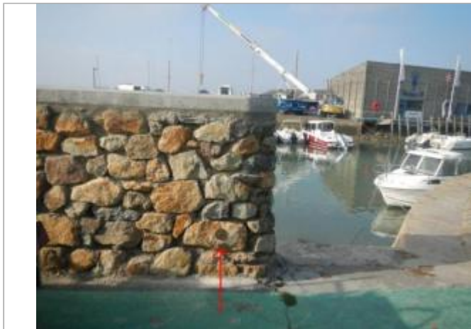
Jetée Jacobsen - Mur d'ancrage
