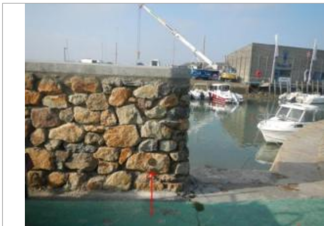
Jetée Jacobsen - Mur d'ancrage
