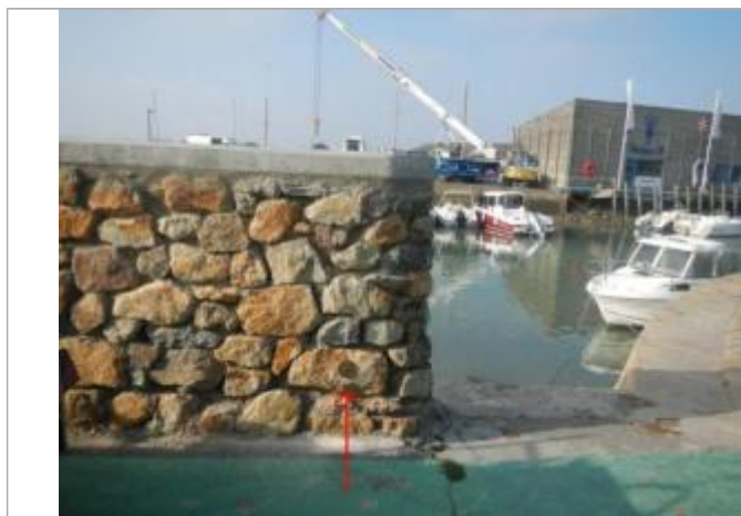
Jetée Jacobsen - Mur d'ancrage
