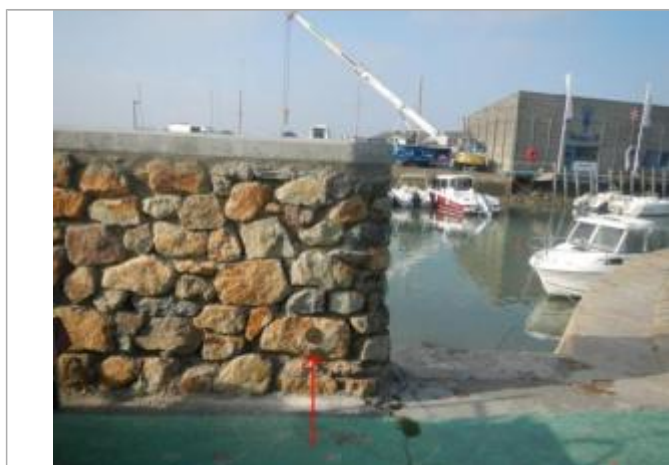
Jetée Jacobsen - Mur d'ancrage
