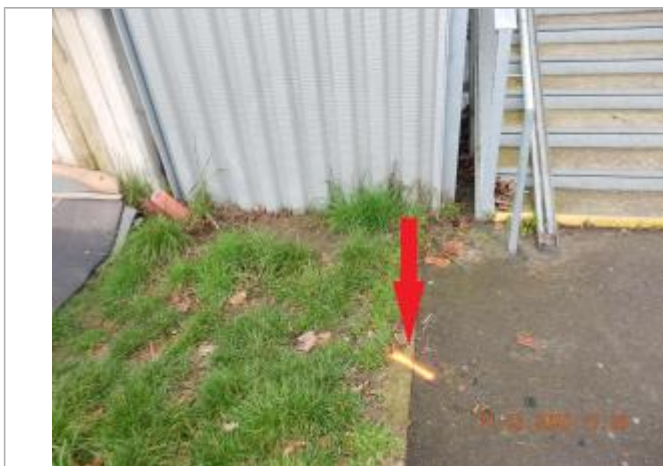
Marque de peinture au pied de l'escalier du pont Guillaume le Conquérant
