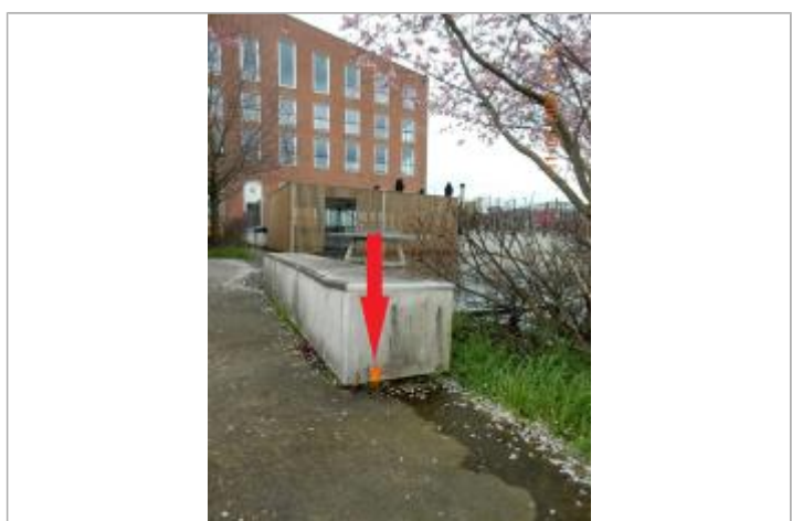
Marque de peinture sur banc en ciment à l'Est du Bt 107
