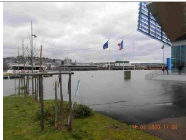
Quai de Seine à l'Ouest du bâtiment de la Métropole
