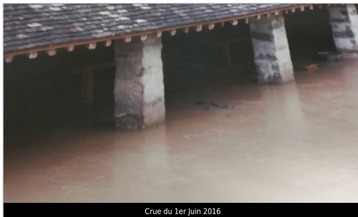
Crue du 1er Juin 2016
