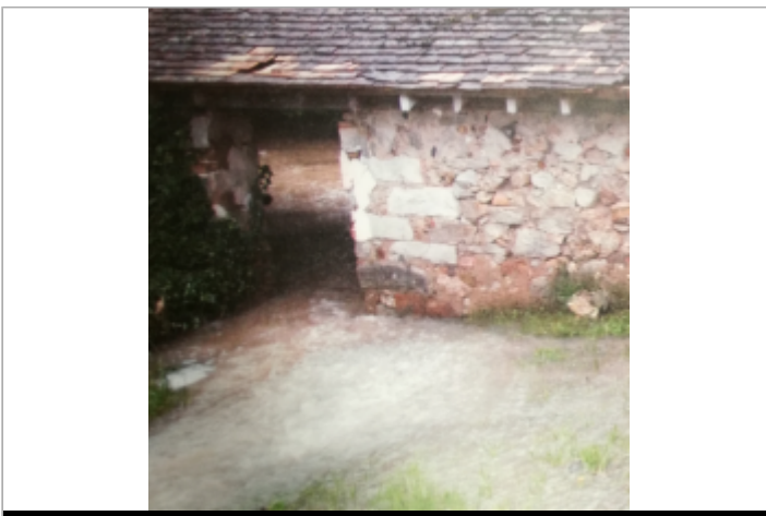
Crue du 1er Juin 2016
