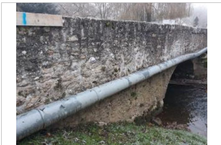
Repère de crue - Seine et Marne Environnement
