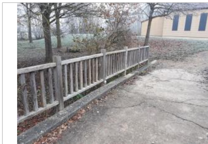
Repère de crue - Seine et Marne Environnement
