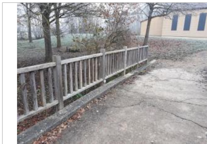
Repère de crue - Seine et Marne Environnement
