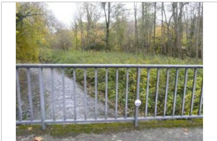
Repère de crue - Seine et Marne Environnement
