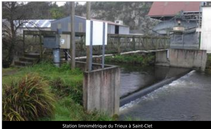
Station limnimétrique du Trieux à Saint-Clet
