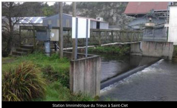
Station limnimétrique du Trieux à Saint-Clet
