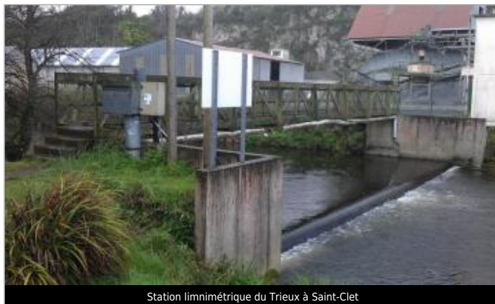
Station limnimétrique du Trieux à Saint-Clet
