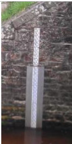
Echelle de la station limnimétrique du Trieux à Saint-Péver Pont de Locminé
